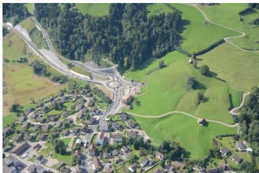
Luftaufnahme Umfahrungsstrasse, Brendikreisel (Foto: TBA Kanton SG)
