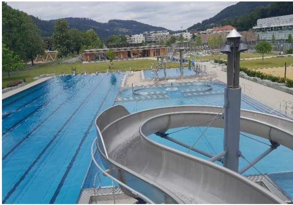
Die Absperrklappen des Schwimmbades werden ersetzt. (Bild zvg)
