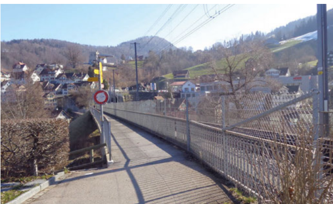
Fussgängersteg Bahnhof Lichtensteig
