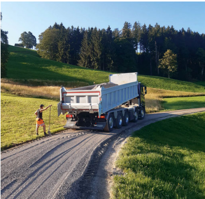
Sanierung der Eschenbergstrasse
