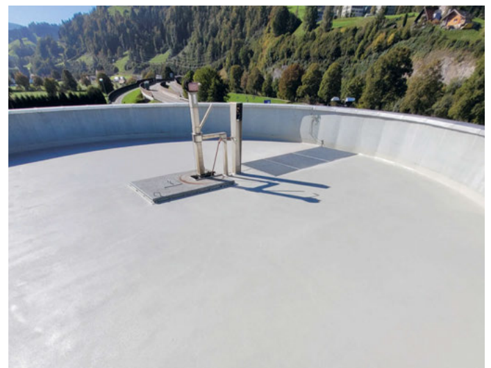
Sanierung des Flachdachs
