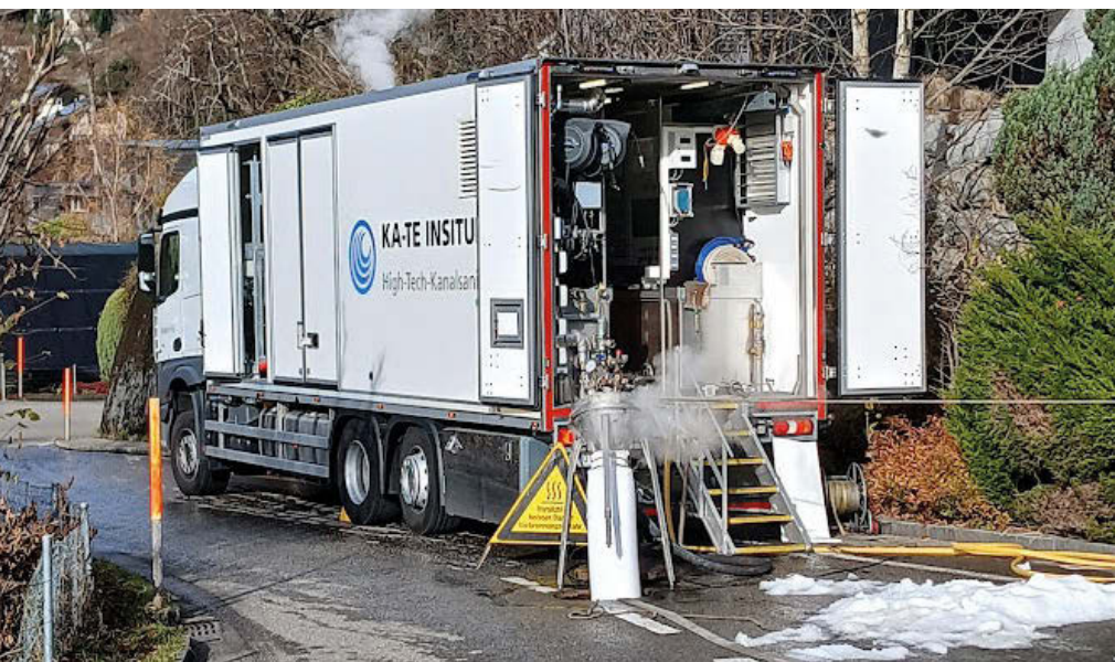
Kanalsanierung mittels Inliner. Bild: zvg
