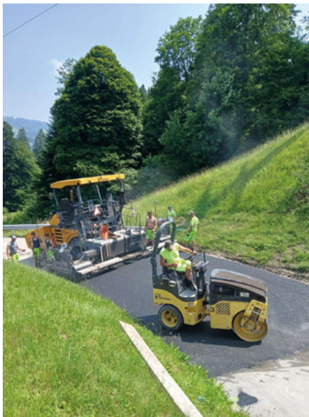
Sanierungsarbeiten an der Schönenbergstrasse. Bilder: zvg
