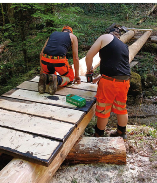
Brückenneubau beim Wanderweg im Rumpf. Bild: zvg
