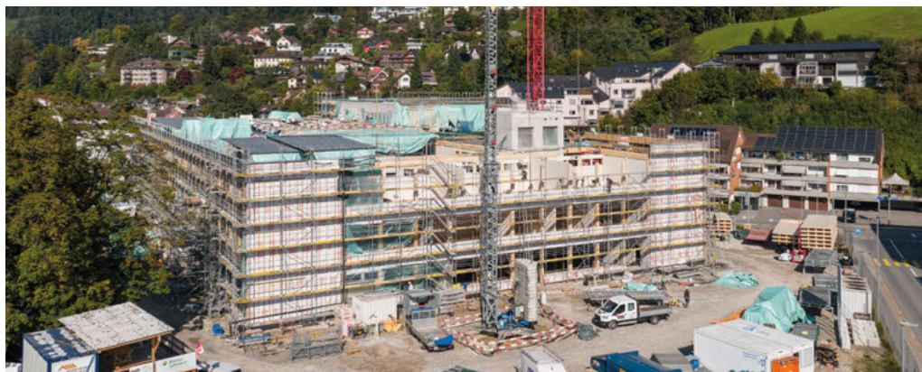
Baufortschritt Neubau Kantonsschule «Campus Wattwil». Bilder: Simon Walther
