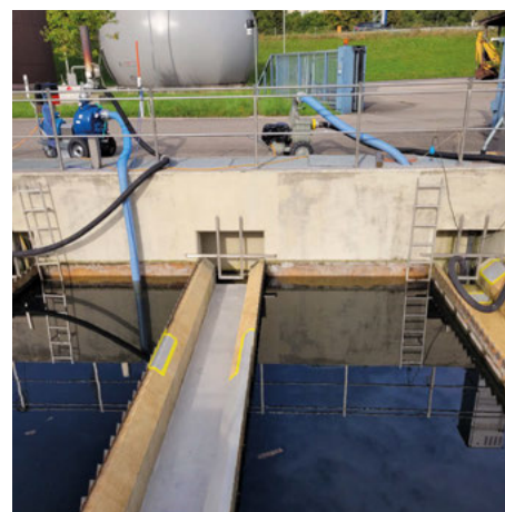
Sanierung der Auslaufrinne im NKB1. Bild: zvg
