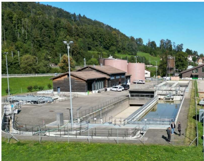
Die Bedachung der ARA erhält eine Photovoltaikanlage und ein Nachklärbecken muss saniert werden. Bild zvg
