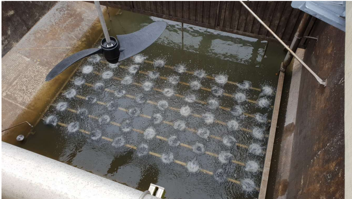
Die Teller-Belüftung produziert Luftbläschen und versorgt damit Bakterien mit Sauerstoff, welche das Abwasser reinigen und stabilisieren. Bild ARA
