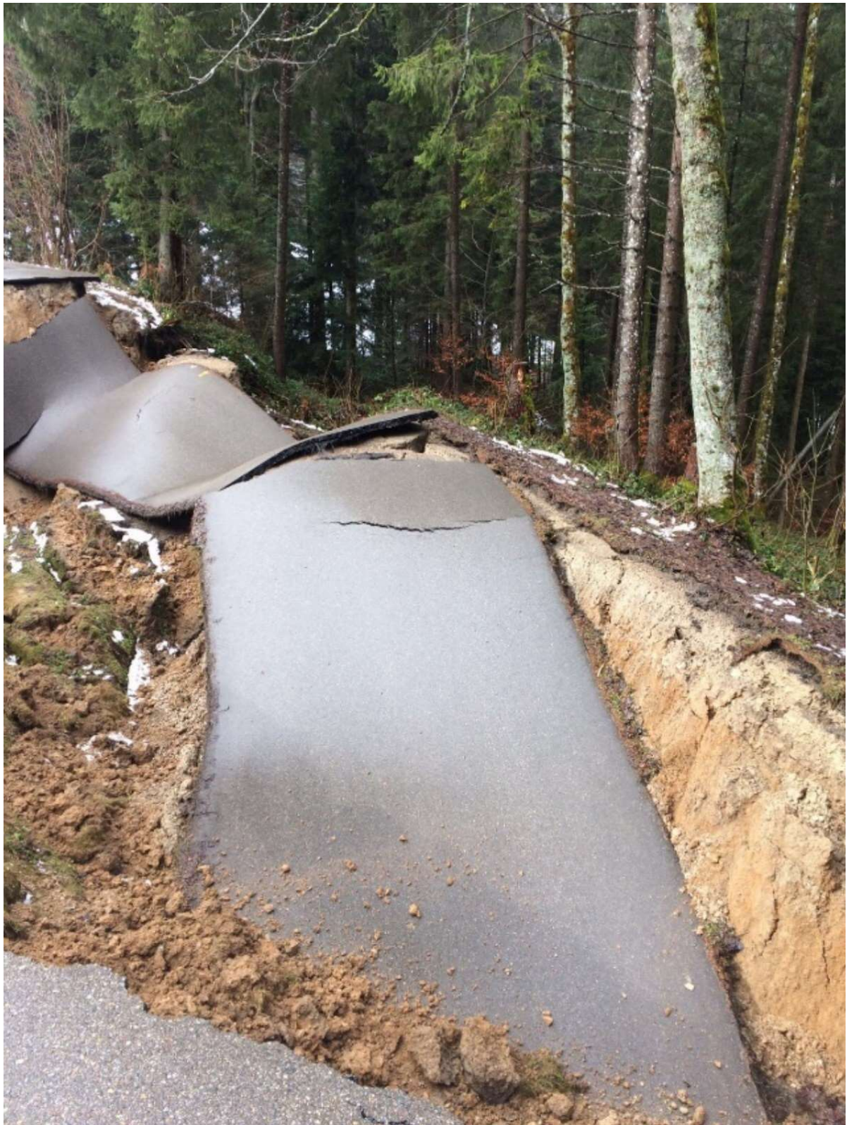
Die Gemeinde Wattwil war aufgrund der geografischen Lage in der Vergangenheit öfters von gravitativen Naturgefahren wie der Hangrutsch Rumpf 2017 betroffen. Bild zvg.
